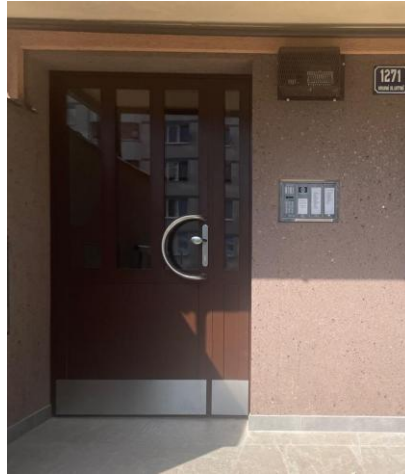
1.máje 1271, Orlová ( nové ocelové dveře JANSEN přední vstup) ( montáž rok 2024 )
