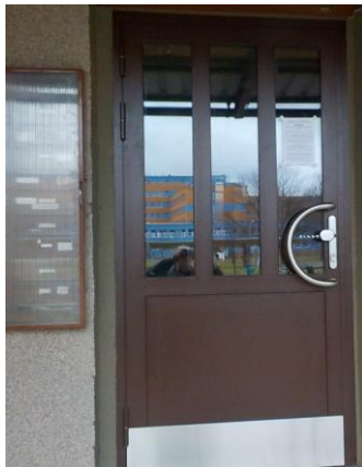
ul. Moskevská 1a, Havířov ( komplet rekonstrukce vstupu, schodiště a chodníku, nové ocelové dveře JANSEN) ( montáž rok 2020 )
