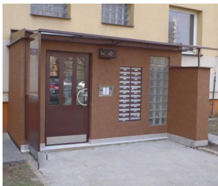
Masarykova 1023 Orlová (nové dveře PV a rekonstrukce komplet) ( montáž rok 2018 )
